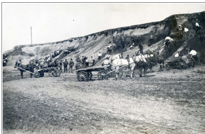
Рис. 3. Дорожные работы в окрестностях Хабаровска. 1926 г.
