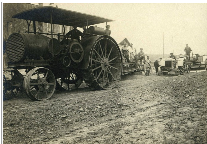
Рис. 4. Выравнивание вспаханного полотна улицы. Работают два трактора «Тайлор» и «Фордзон» с грейдерами. Хабаровск, 1926
