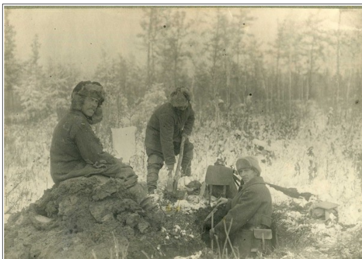
Рис. 1. Дорожные работы в окрестностях Хабаровска. 1926 г.
