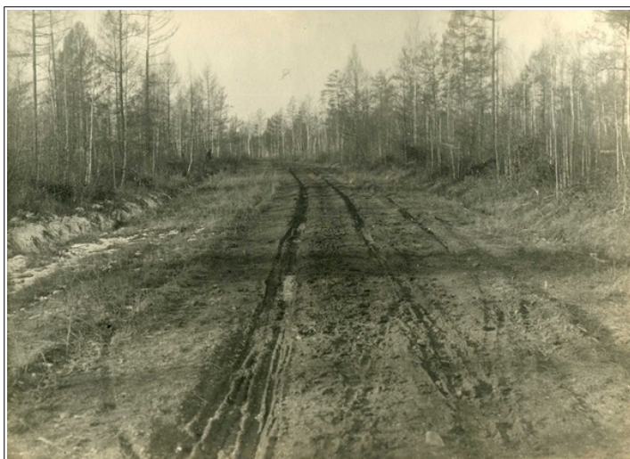
Рис. 2. Дорожные работы в окрестностях Хабаровска. 1926 г.
